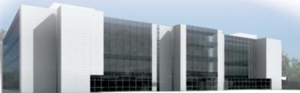
Futur siège Le Foyer actuellement en construction à Leudelange
